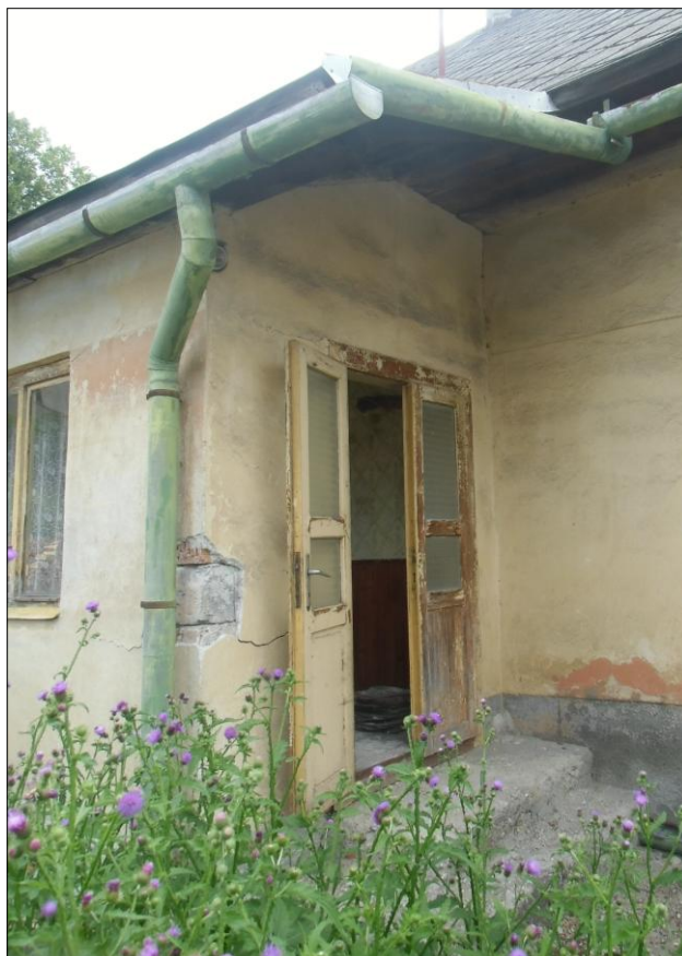
Pohľad na pôvodnú prístavbu, ktorá bola odstránená – stav pred rekonštrukciou.
