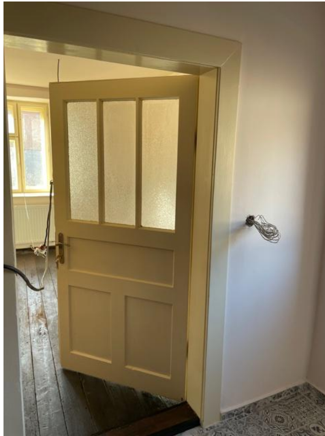
Opravené pôvodné dvere z chodby do spoločenskej miestnosti 1.02 – stav po rekonštrukcii.
