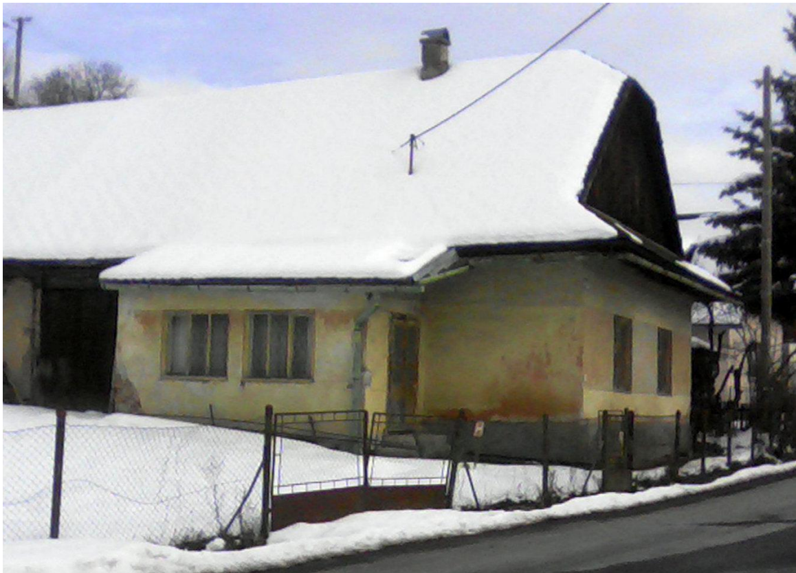
Pohľad z boku – stav pred rekonštrukciou.
