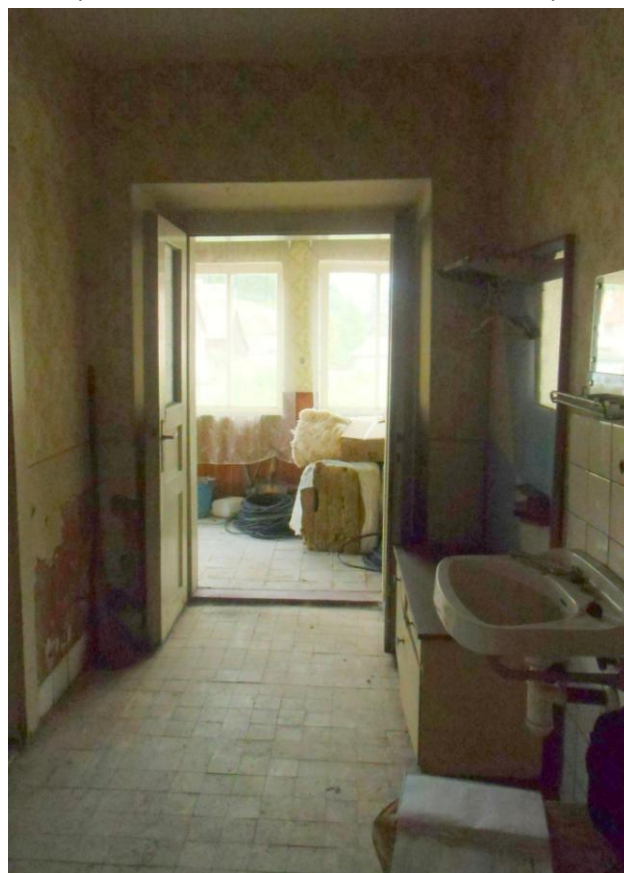
Chodba – stav pred rekonštrukciou (m.č. 1.01).
