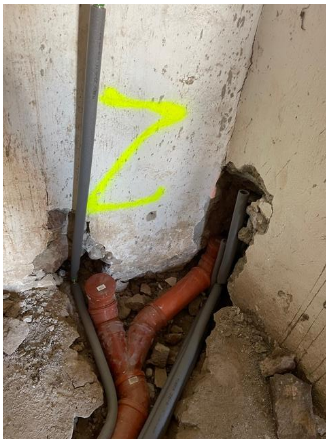
Rozvody vody a kanalizácie v budúcej kúpeľni.
