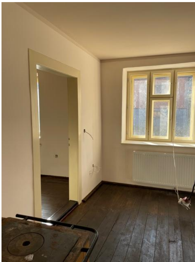
Spoločenská miestnosť č. 1.02 s prechodom do ďalšej miestnosti č. 1.03 – stav po rekonštrukcii.
