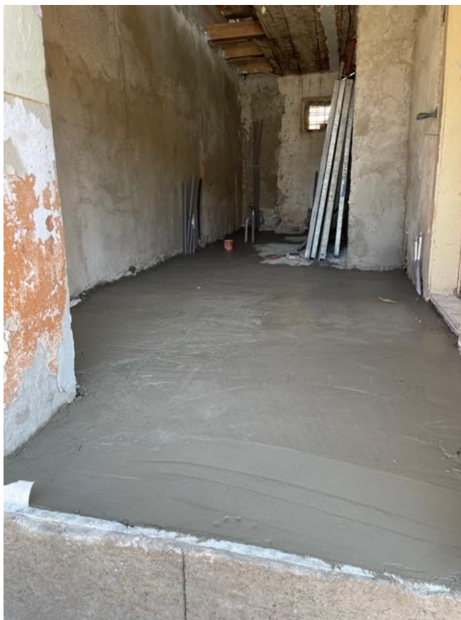
Podlaha chodby a kúpeľne – stav po zaliatí rozvodov.
