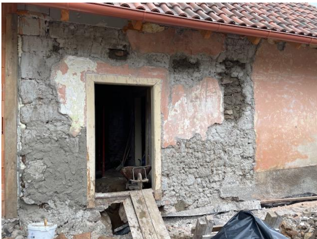
Vstupné dvere do budúceho komunitného a spoločenského centra – stav pre obnovu.
