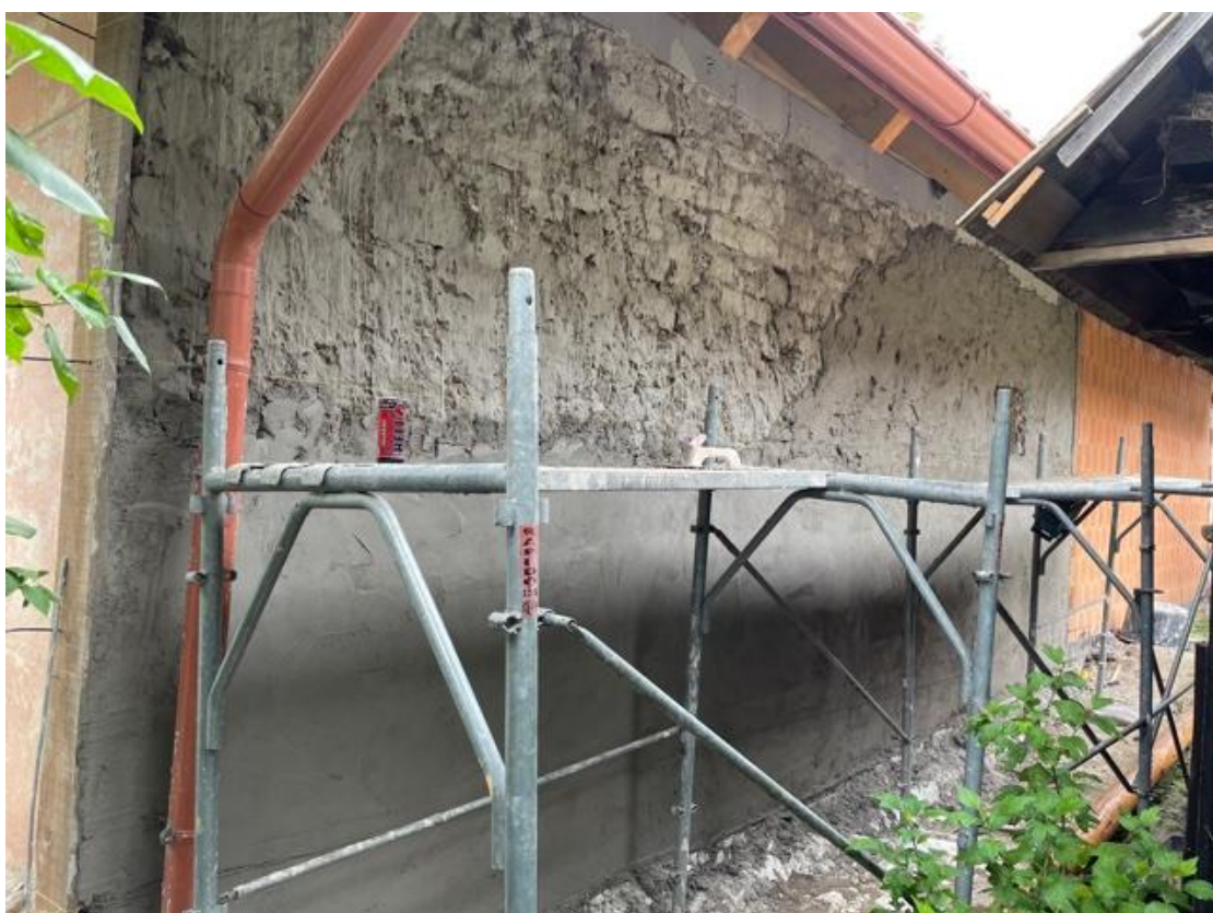
Nové vápenné vonkajšie jadrové omietky na časti bočnej susedskej fasáde.
