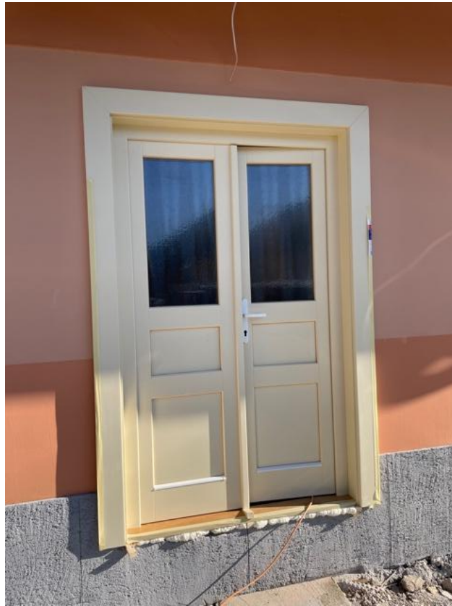
Vstupné dvere do centra – stav po osadení nových dverí.
