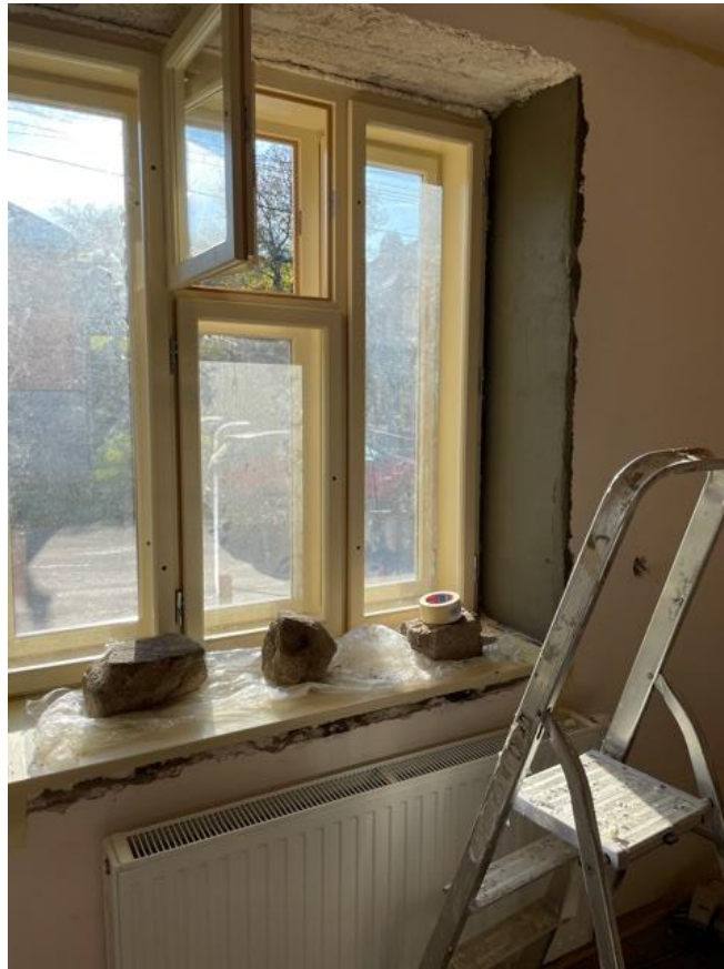
Stav po osadení vyrobenej novej repliky okna.
