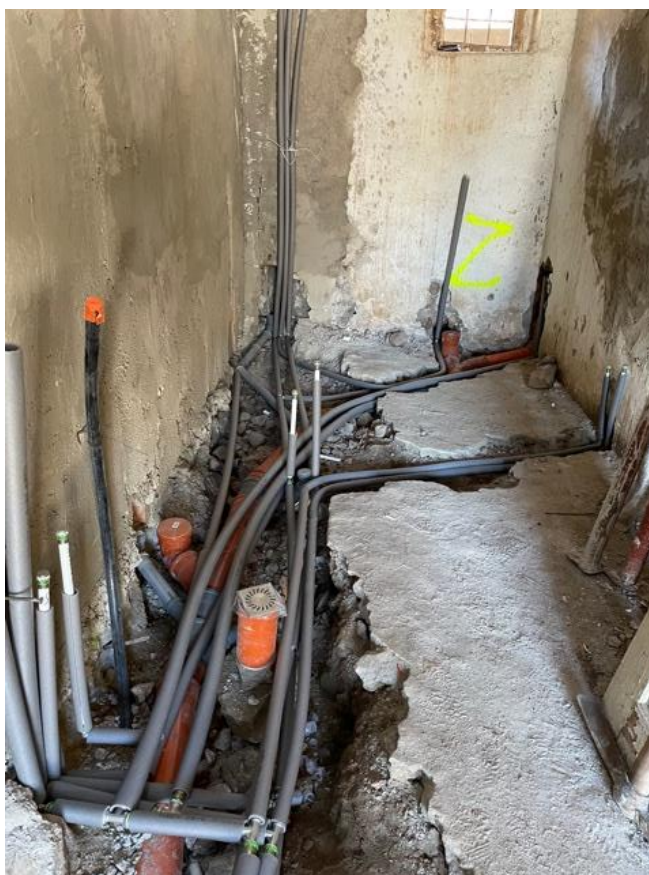
Nové rozvody kanalizácie a vody v miestnostiach 1.01 (chodba) a 1.05 (hygienická miestnosť).
