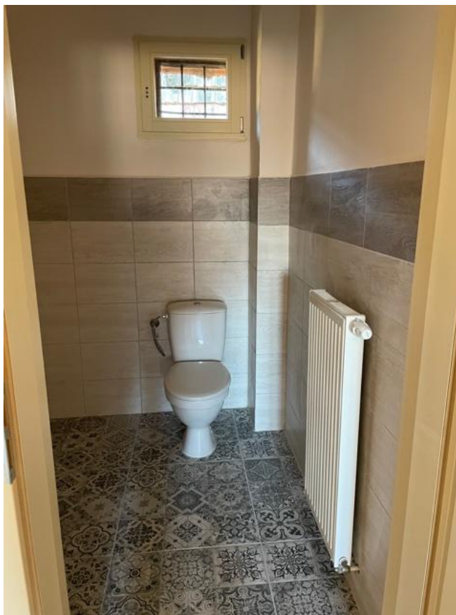
Miestnosť č. 1.05 – hygienická bunka s novou toaletou – stav po rekonštrukcii.
