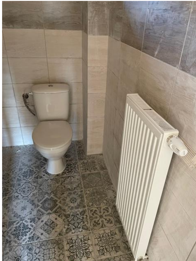
Pohľad do kúpeľne – stav po ukončení prác.
