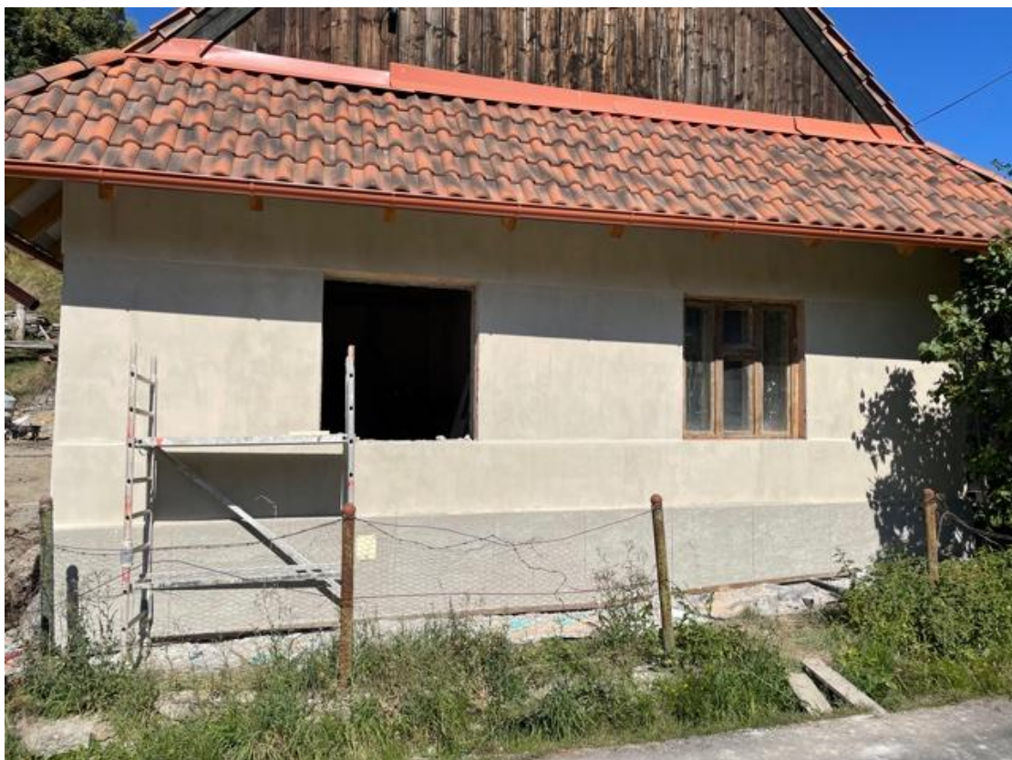
Nové omietky čelnej fasády so zachovaním pôvodného členenia fasády typickej pre našu obec.
