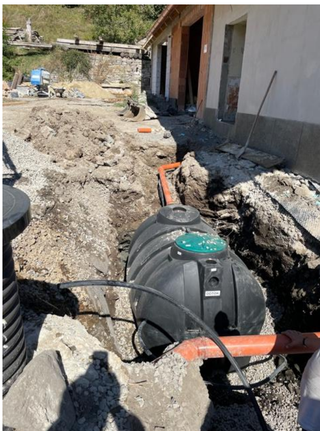
Osadená nová plastová žumpa s kanalizačnými vpustami.
