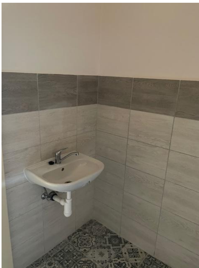
Miestnosť č. 1.05 – hygienická bunka s novým umývadlom – stav po rekonštrukcii.
