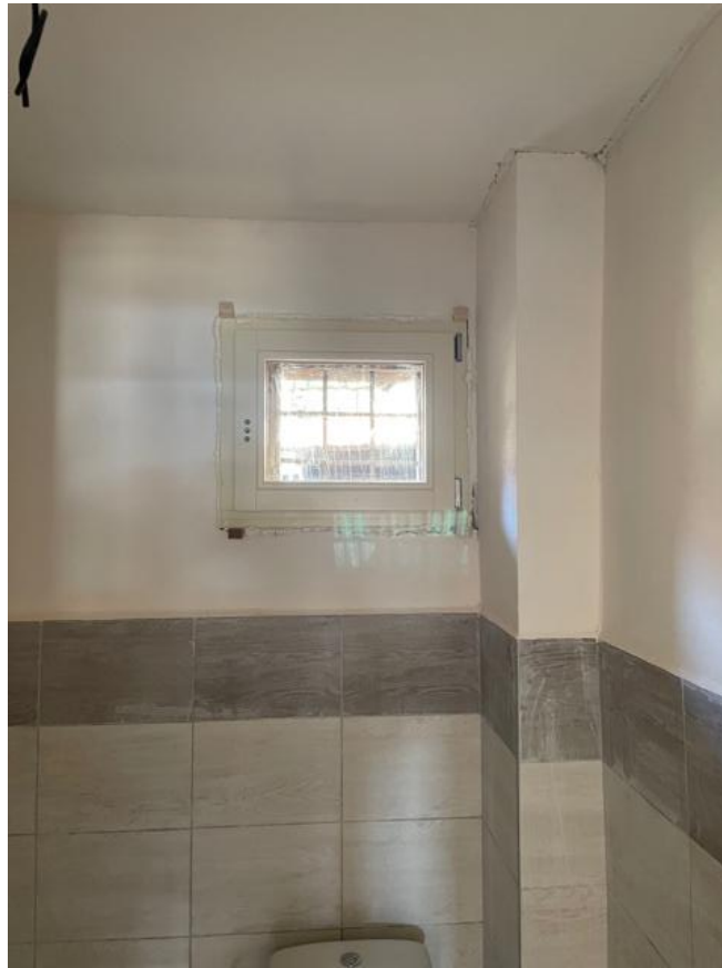
Nové omietky kúpeľne a novým obkladom.
