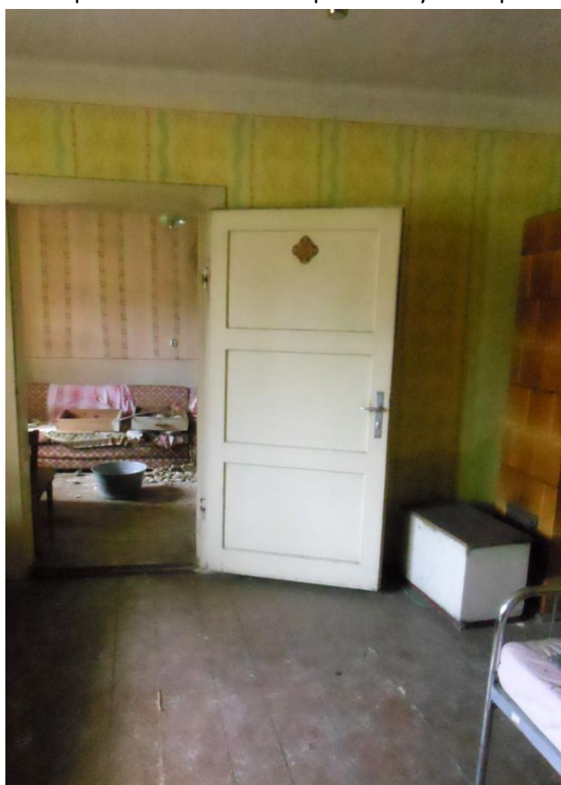
Pohľad z miestnosti č. 1.03 do miestnosti č. 1.02 – stav pred rekonštrukciou.
