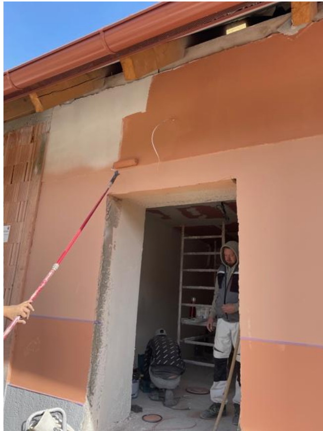
Záverečný farebný vápenný náter bočnej steny.
