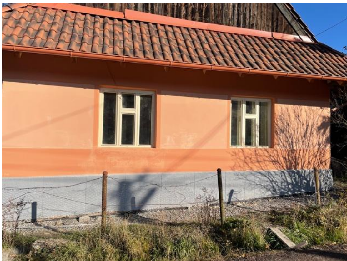
Celkový pohľad na uličnú fasádu – stav po rekonštrukcii.
