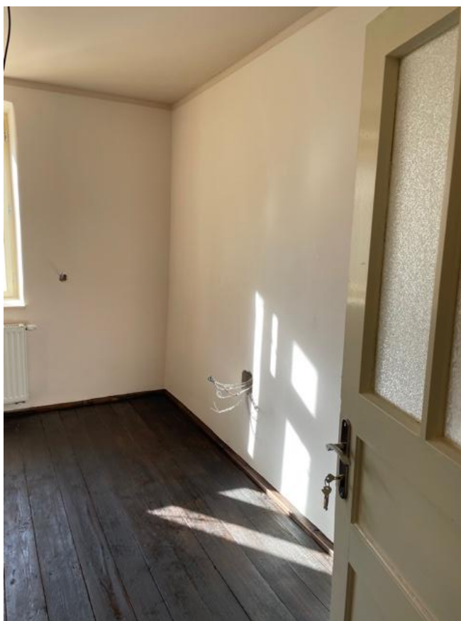
Nové omietky a opravená pôvodná drevená podlaha - stav po rekonštrukcii.
