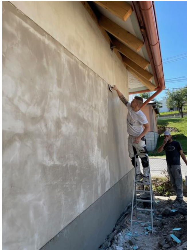
Začistovanie novej hladkej omietky na bočnej susedskej fasáde.
