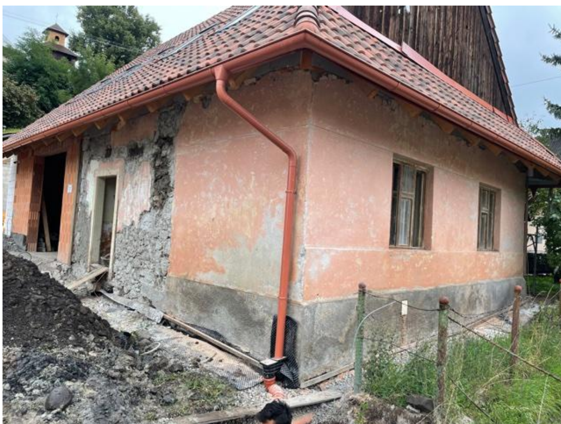
Čelná a bočná fasáda – stav po odstránení nepôvodnej prístavby.
