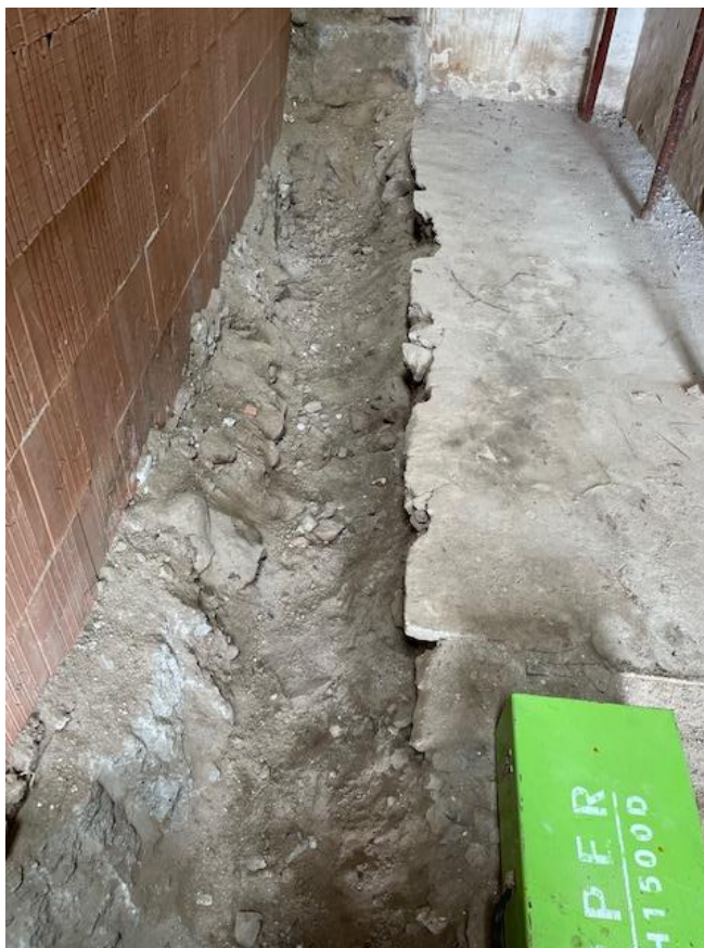
Výkopové práce v chodbe – stav pred osadením rozvodov kanalizácie a vody.
