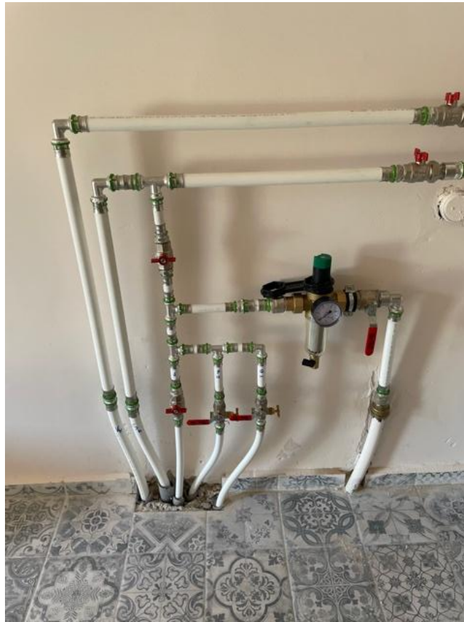
Nové rozvody kúrenia – stav po ukončení prác.
