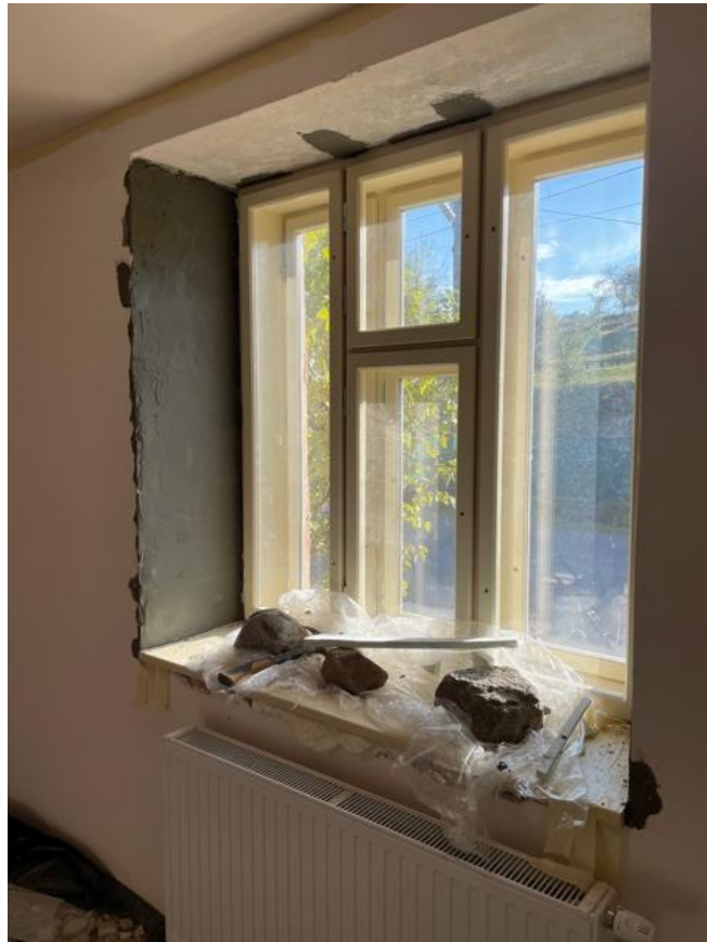
Nové okenné jadrové omietky, osadený nový radiátor v spoločenskej miestnosti.
