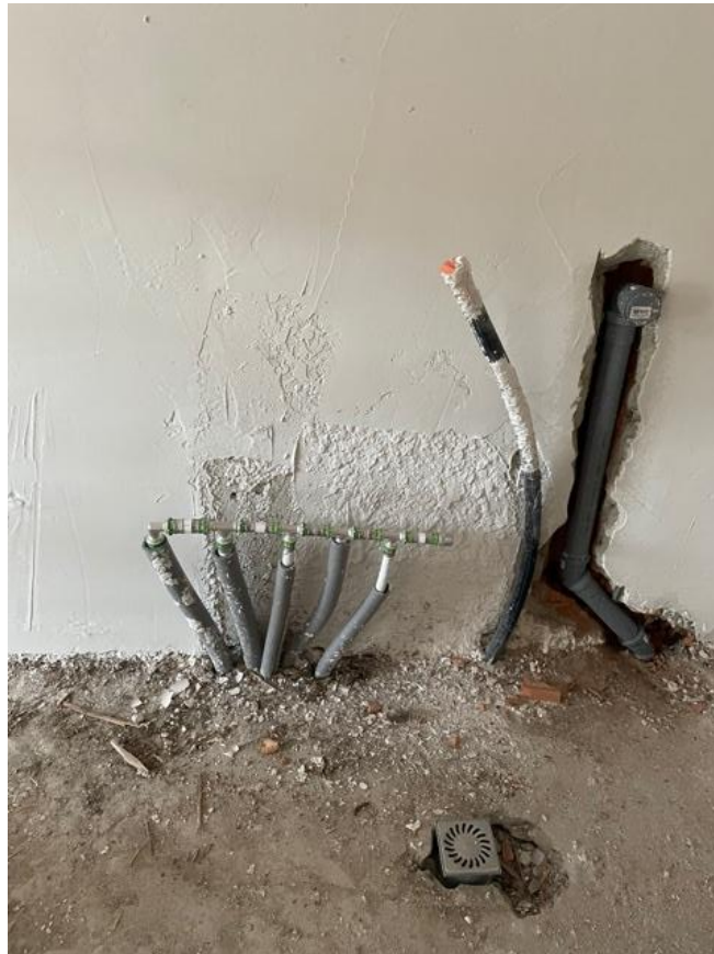
Rozvody vody – stav po montáži vykurovacieho potrubia a pred osadením a elektro kotla.
