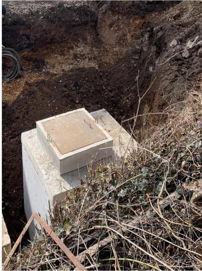
Osadenie vodomernej šachty.
