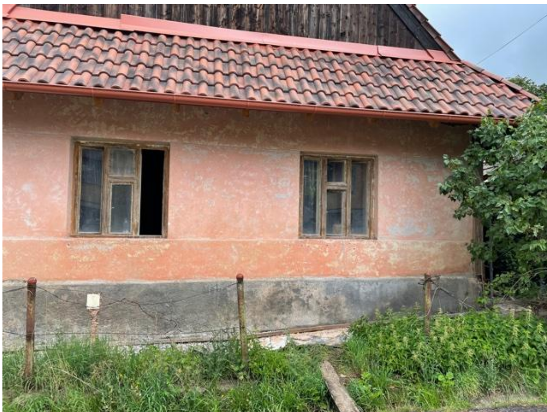
Pohľad na čelnú uličnú fasádu – stav pred rekonštrukciou.
