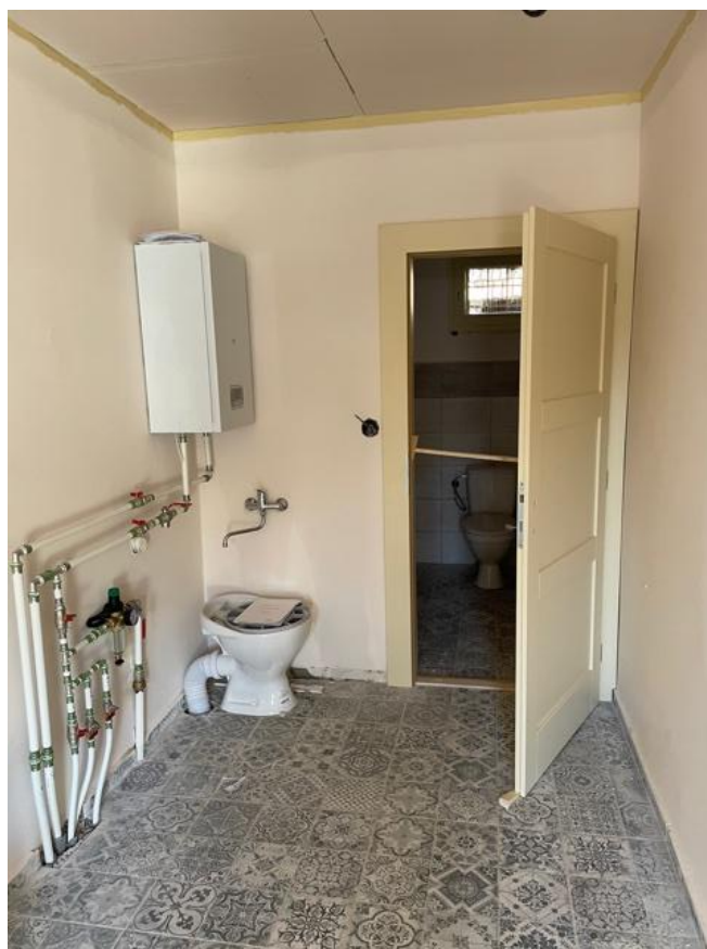
Nová podlaha chodby s novými dvermi do kúpeľne.
