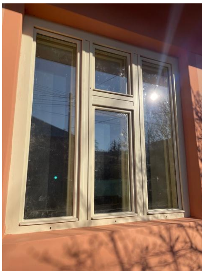
Pohľad na nové repliky okenných výplní – stav po rekonštrukcii.
