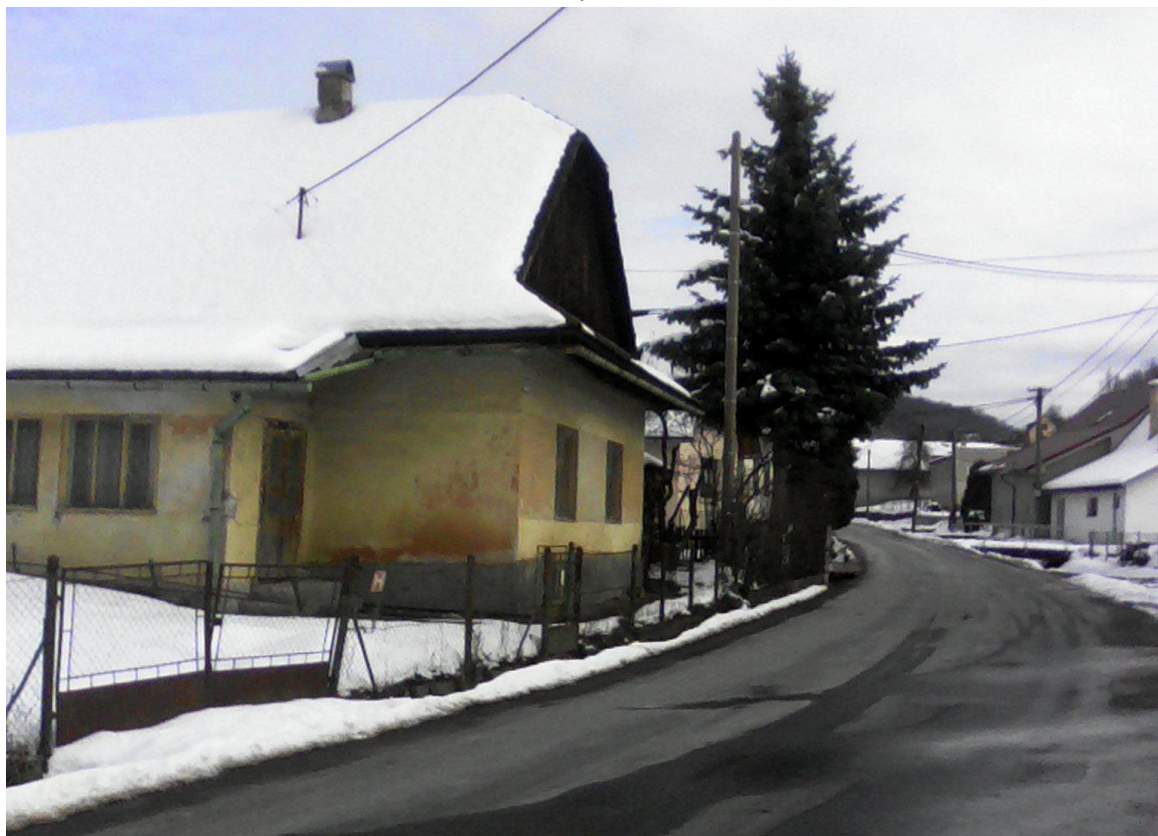
Celkový pohľad – stav pred rekonštrukciou.
