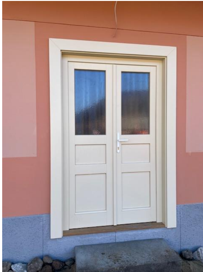
Vstupné dvere a fasádny úprava – stav po ukončení prác.
