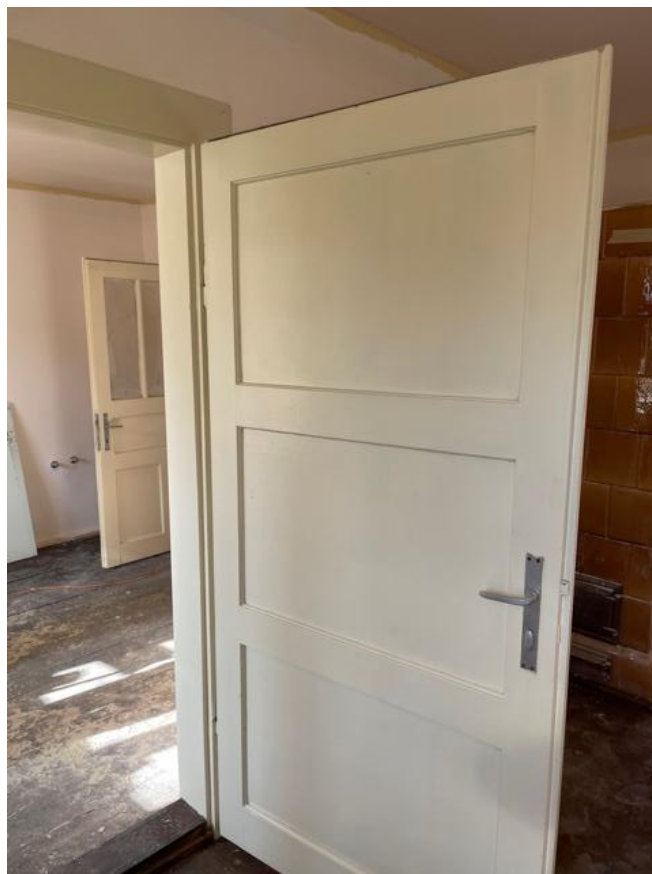
Pôvodné dvere so zárubňou – stav po ich obnove.
