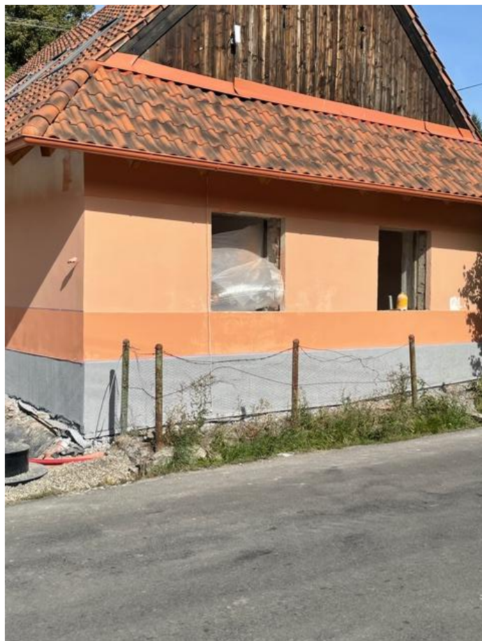
Pohľad na uličnú fasádu – stav po obnove.
