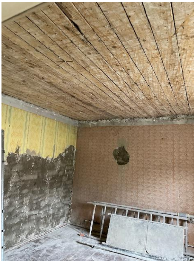
Miestnosť č. 1.03 – stav po odstránení poškodených omietok stropu, oprava časti omietok stien.
