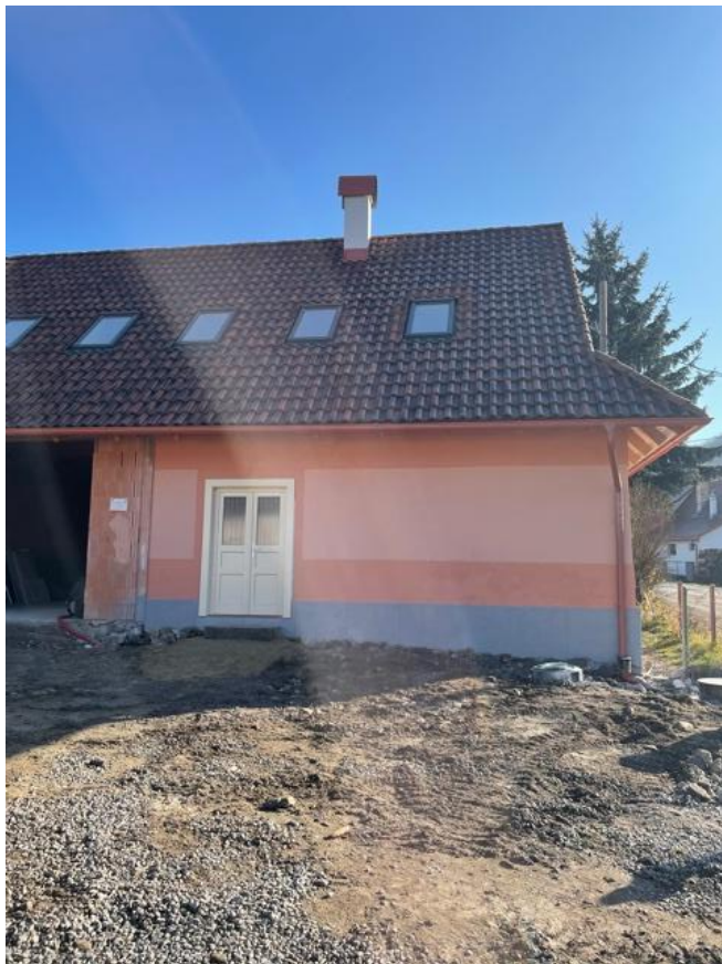
Celkový pohľad na bočnú fasádu – stav po rekonštrukcii.
